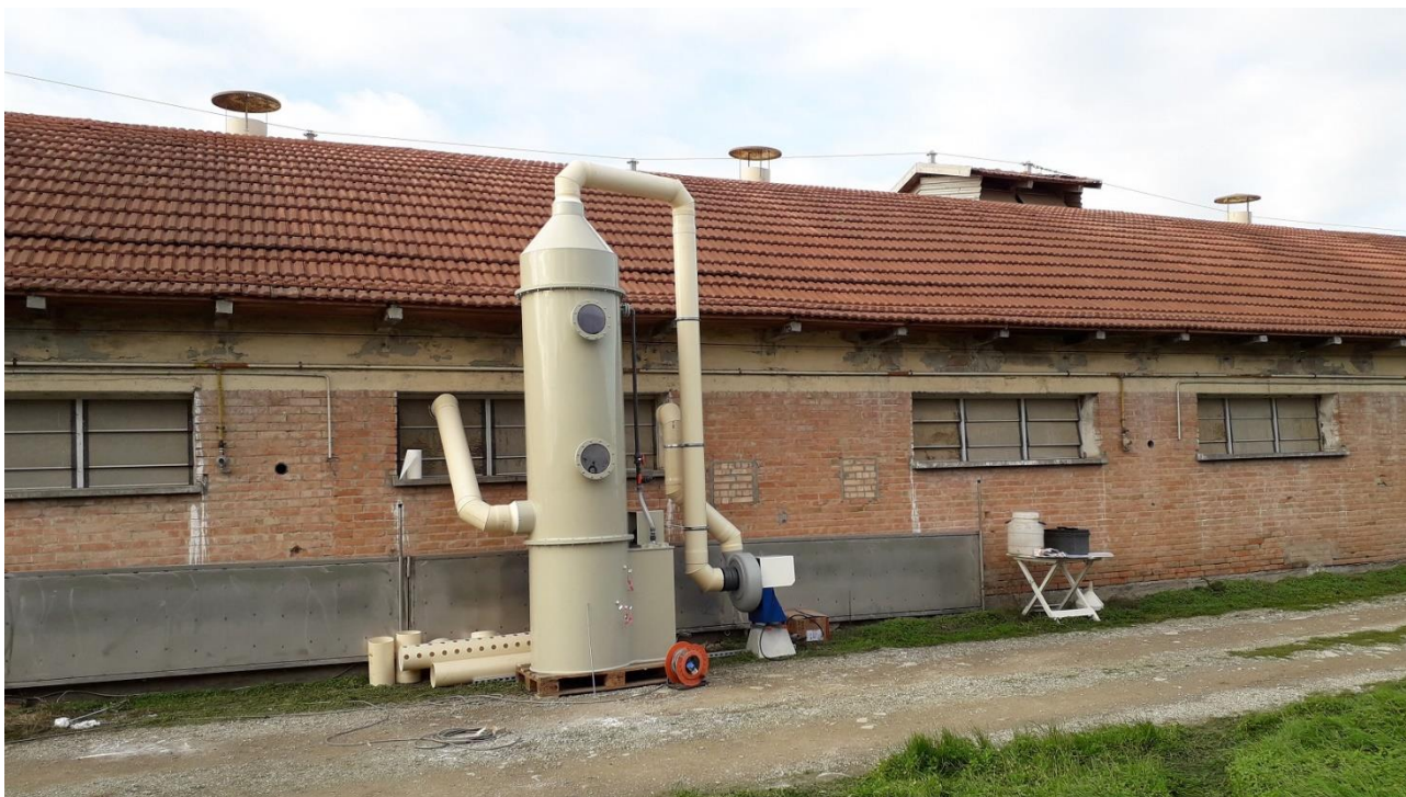
Il sistema Ammonia Washing Machine in fase di allestimento
